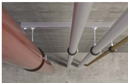
Fissaggio di tubazioni.
