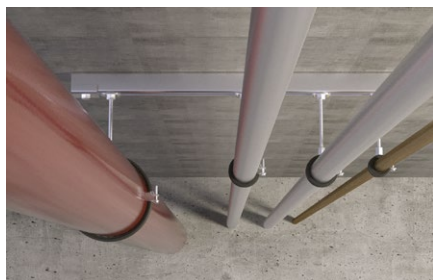
Fissaggio di tubazioni.
