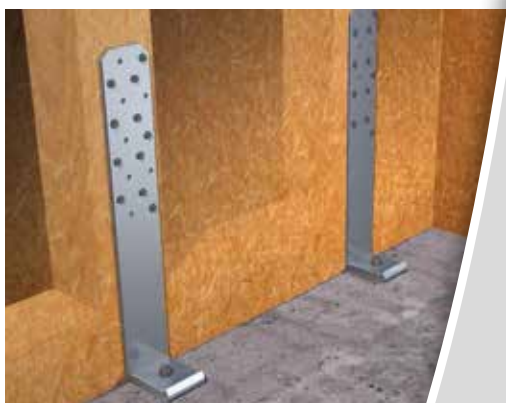
Fixation d'équerres sur chape béton
