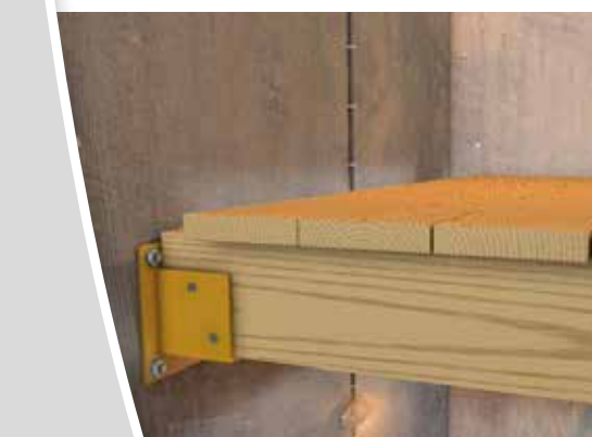
Fixation de connecteurs métalliques sur mur béton
