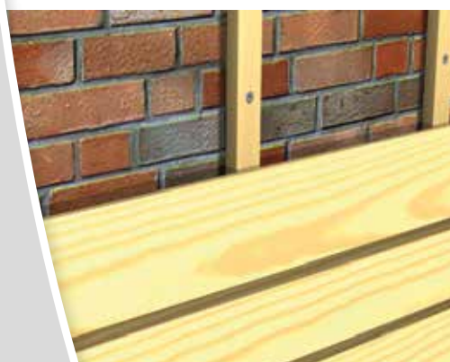
Fixation de tasseaux sur maçonnerie pleine
