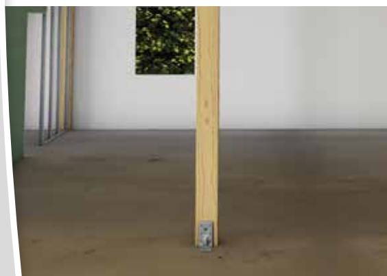
Fixation d'équerres Tirefond et/ou vis pour connecteurs
