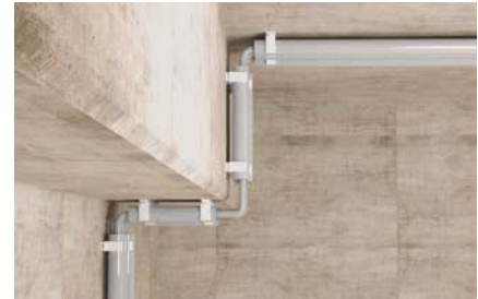
Befestigung von Kunststoff-Isolierrohren
