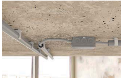
Befestigung von Kunststoff-Isolierrohren
